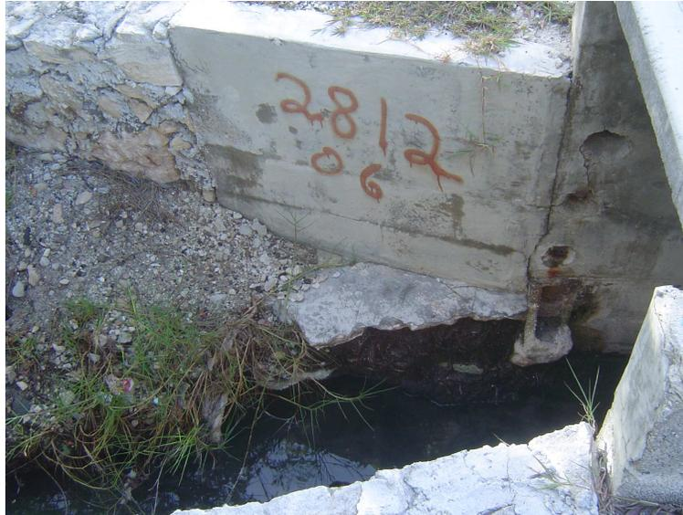
**Foto 14. Detalle de la descarga de agua residual frente Plaza Caracol.**
