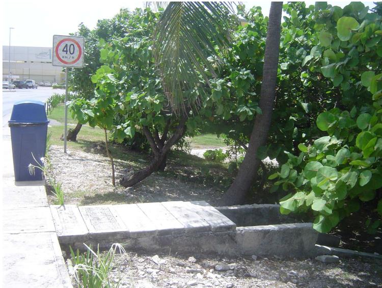
**Foto 20. Descarga pluvial frente al estacionamiento de plaza Caracol.**
